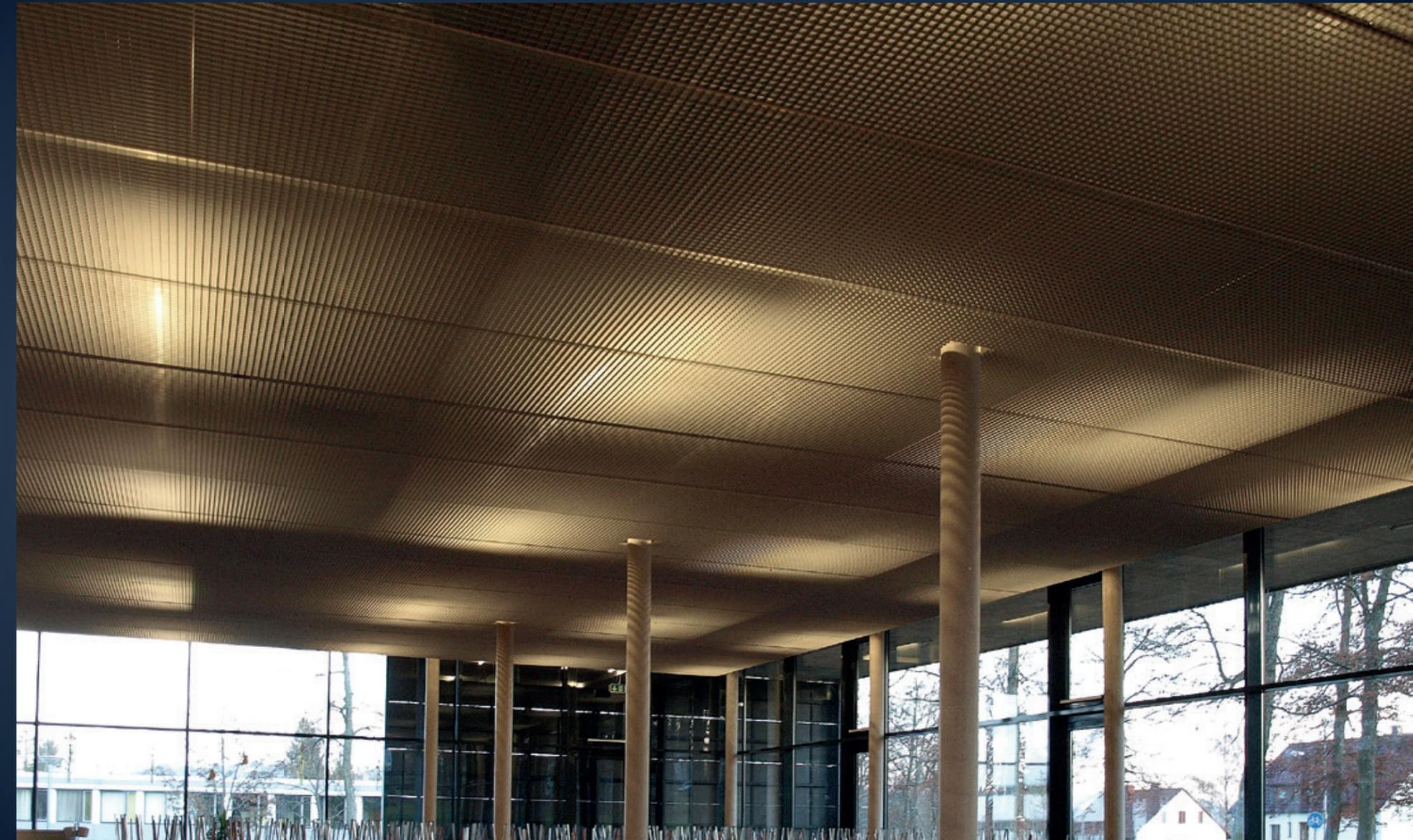
Die Einbauhöhe der Leuchtmittel ist bei Lichtrasterdecken sehr variabel. Zum Beispiel benötigen lichtemittierende Dioden vergleichsweise wenig Platz innerhalb der abgehängten Lichtdecke. Leuchtstofflampen hingegen erfordern eine höhere Einbautiefe. So hat der Planer einen maximalen Handlungsfreiraum für die Konzeption der gewünschten Beleuchtungseffekte.
