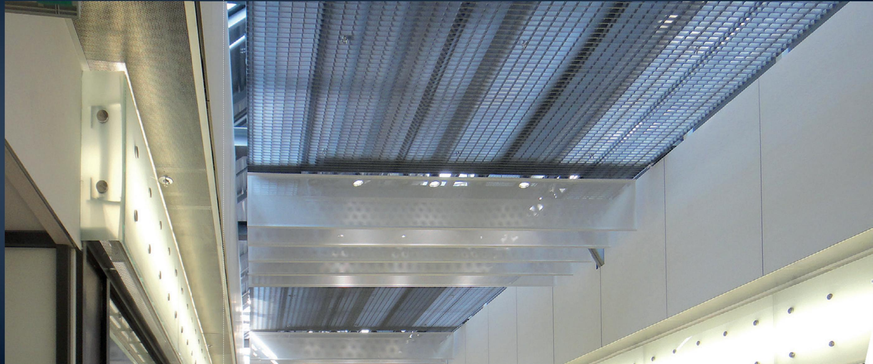
Die Lichtdurchlässigkeit der verwendeten Materialien liegt - je nach Ausführung - zwischen 30 und 50%. Beim Einsatz einer doppelten Membranfolie sorgt eine zusätzliche Sicherheitsschicht für das Verhindern von Verschmutzungen. Für Lichtdecken mit besonderen Anforderungen an den Brandschutz (A2) werden Glasfasergewebefolien eingesetzt.
