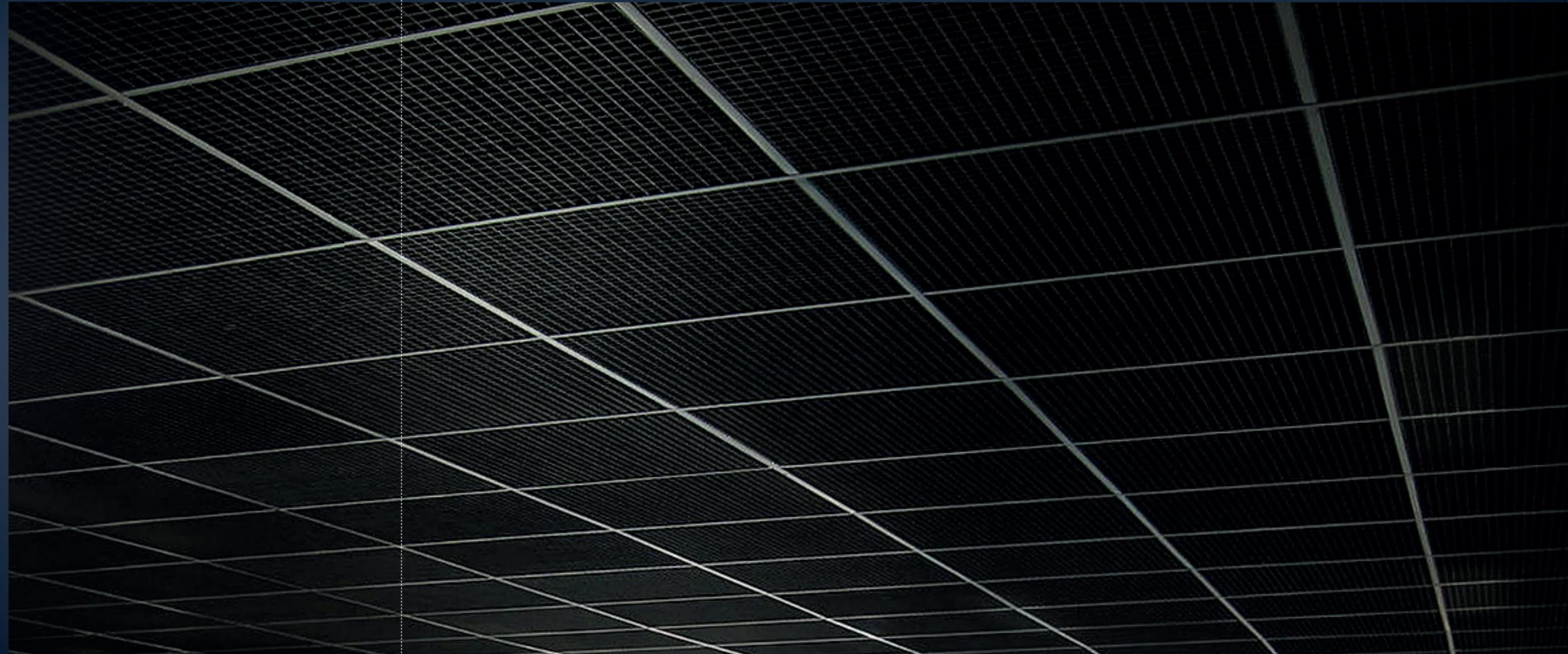
Sinnvoll ist bei Lichtrasterdecken eine Kombination aus Tages- und Kunstlichteinsatz. Bei Bedarf wird dabei Tageslicht durch künstliches Licht mit gleicher Lichtfarbe ergänzt oder ersetzt. Eine andere oder sogar wechselnde Farbgebung kann dann bei Verwendung von Kunstlicht am Abend durch entsprechend farbige Leuchtmittel bzw. durch variables Lichtmanagement erfolgen.
